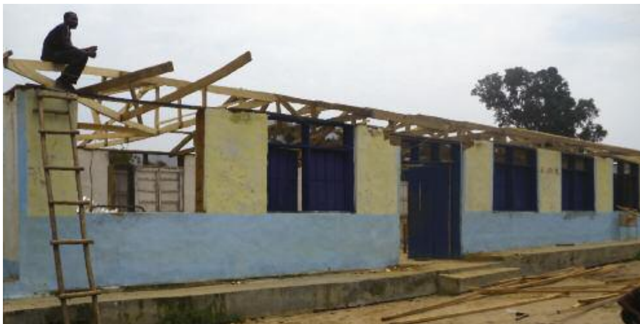
Enkele dagen na het onweer wordt het dak van de post-op hersteld.
