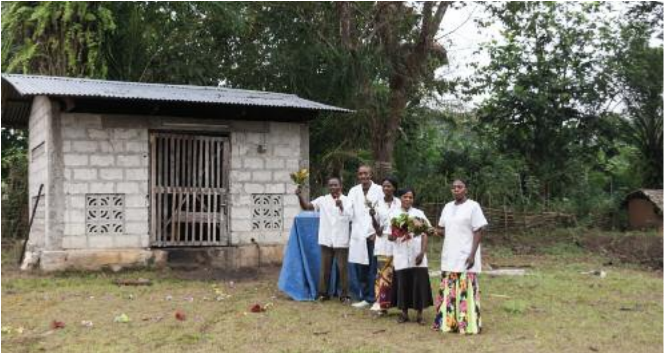
Enkele verpleegkundigen verwelkomen ons bij de nieuwe generator.
