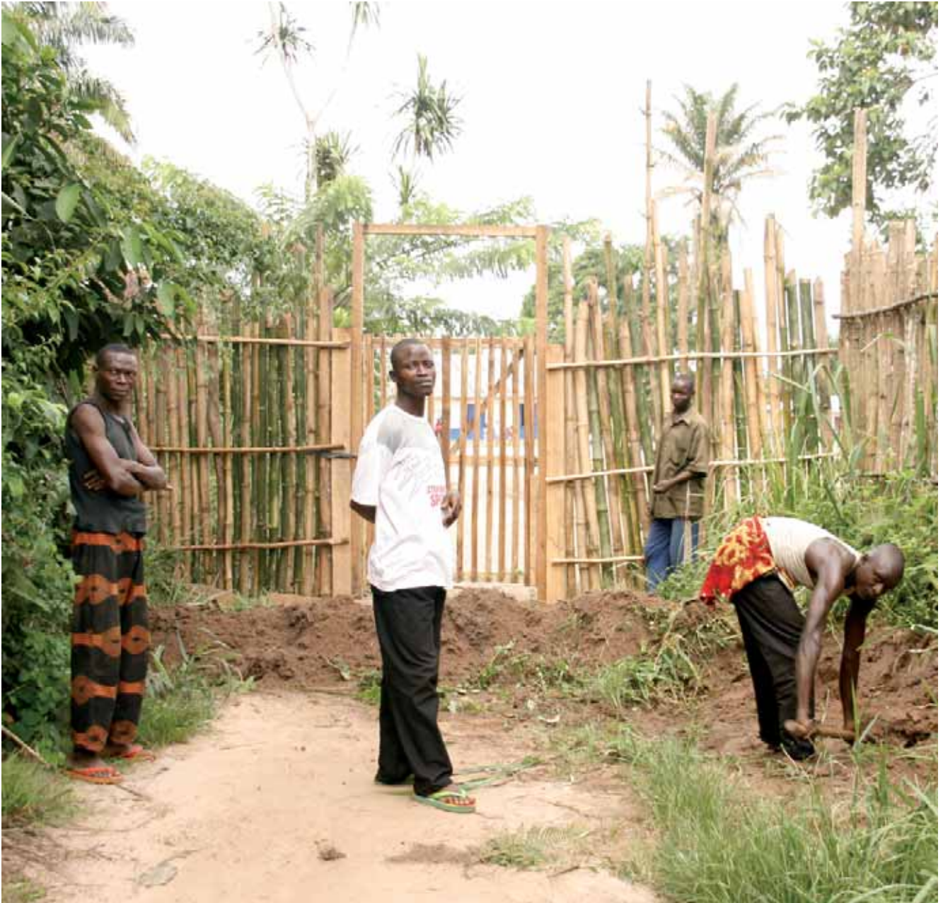
verkeersdrempel aan de kleine poort
